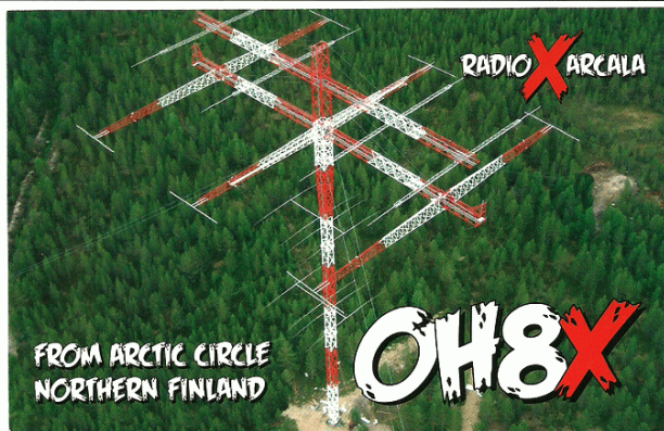
Figura 23 - Essa é a famosa Yagi de 3 elementos para 80m da Radio Arcala!! Trata-se de um grupo de radioamadores finlandeses que construíram esse arranjo: 3 elem. 80m + 4 el 40m + 2x 4 el. 20m. A torre inteira é giratória e o motor na base é gigantesco. A torre tem 80m de altura total.
